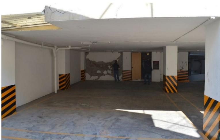
Figura 10. Contraste entre muros colindantes (izquierda) –perpendiculares a calle– y muros paralelos a calle (fondo) en edificio Oaxaca 80
