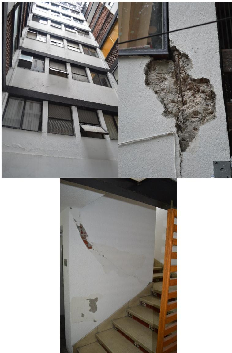
Figura 7. Daños observados en elementos no estructurales en el edificio Amsterdam 82 (dirección paralela a calle)
