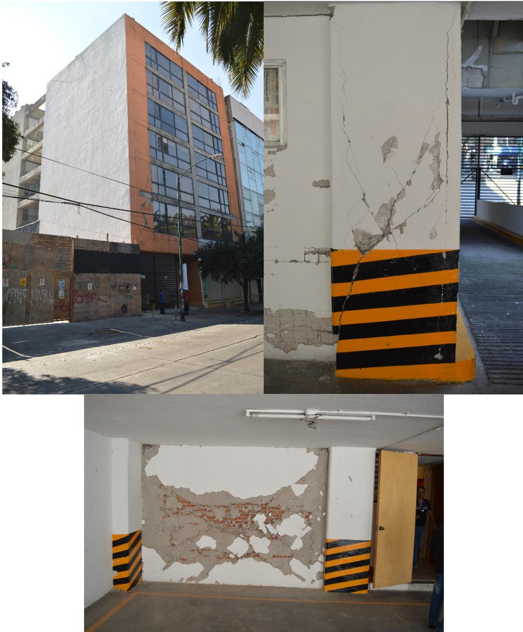
Figura 6. Daños observados en elementos estructurales y no estructurales en el edificio Oaxaca 80 (dirección paralela a calle)
