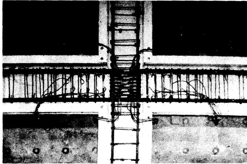
a) Disposición del refuerzo antes de colar el concreto
